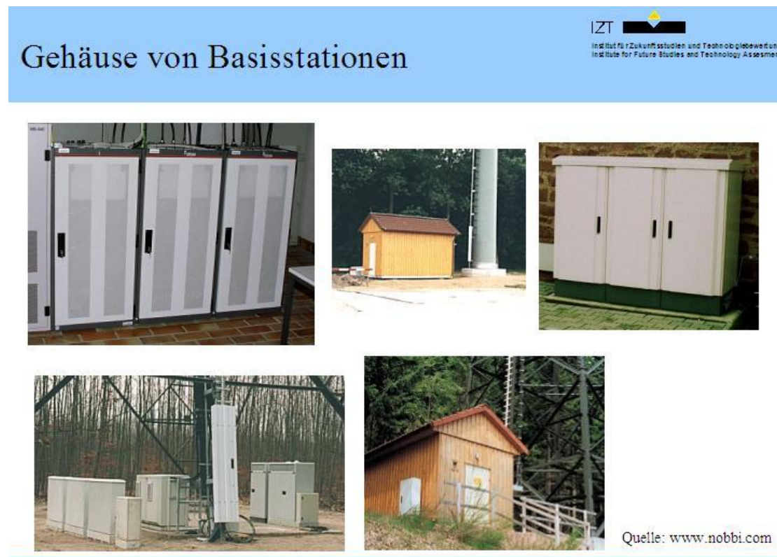
Abbildung 7: Gehäuse von Mobilfunkstationen.
