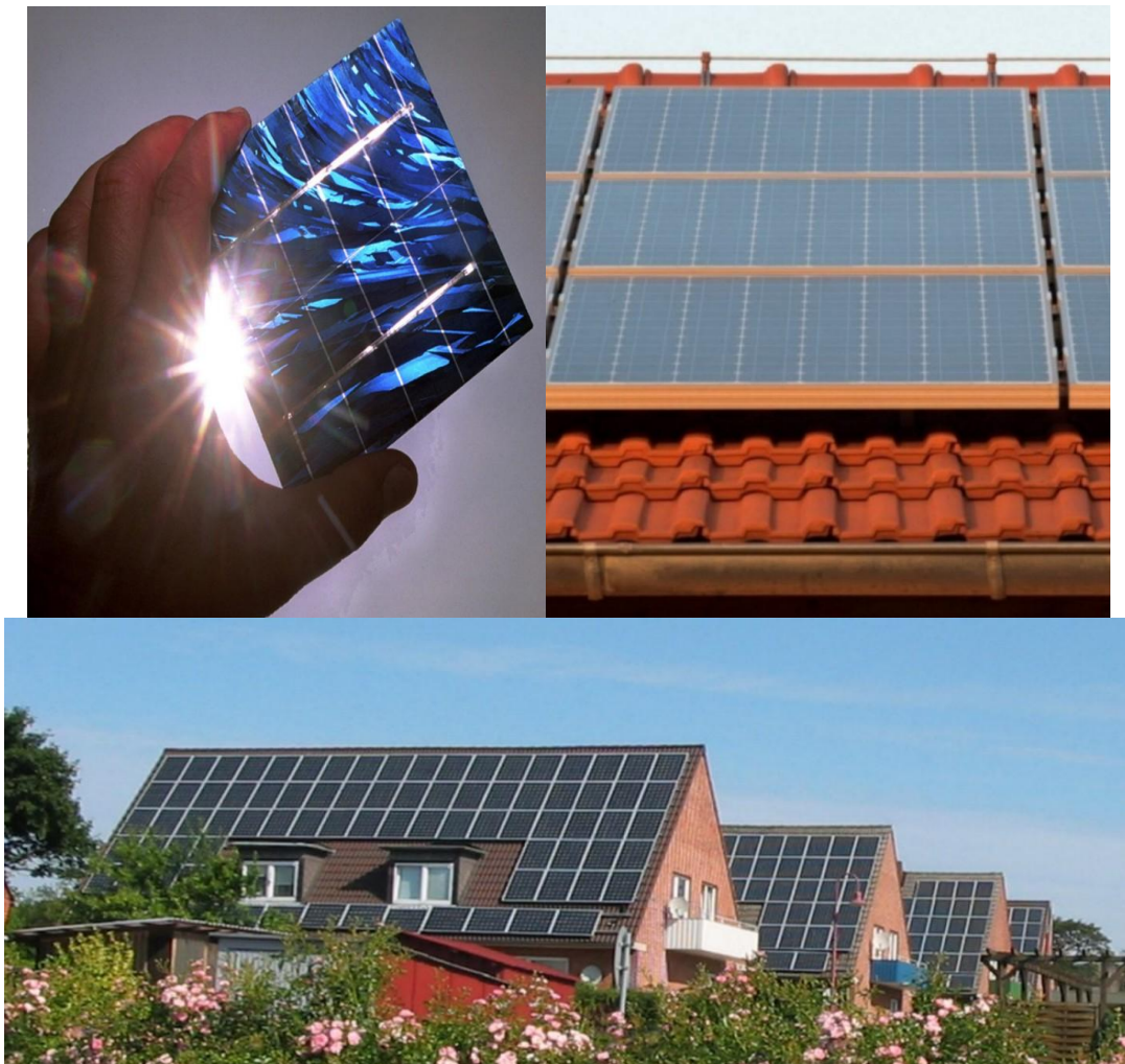
Abbildung 21: Solarzelle (links), Solarmodule (rechts) und Solaranlage (unten).
