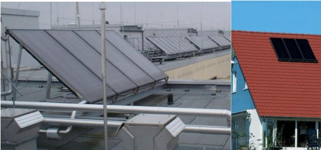
Abbildung 3-4: Das linke Bild zeigt viele Solarkollektoren auf dem einem Hochhaus. Mit den Solarkollektoren wird heißes Wasser für mehr als einhundert Familien hergestellt. In den dicken Rohren fließt das heiße Wasser in einen großen Tank und von dort aus in die Bäder der Wohnungen. Das rechte Bild zeigt auch einen Solarkollektor. Mit ihm wird heißes Wasser zum Baden und Duschen für eine Familie hergestellt.
