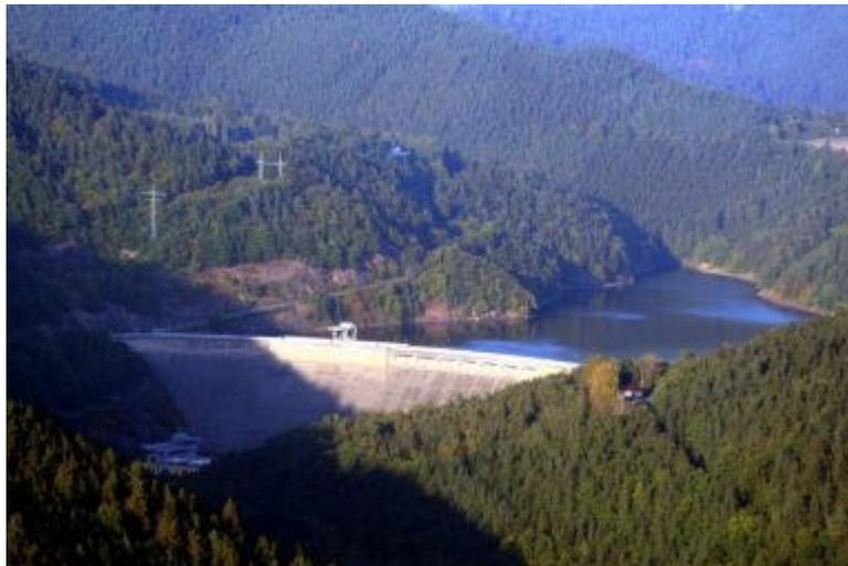
Abbildung 3-11: Das Bild zeigt die Hohewarttalsperre. Du kannst die Staumauer und den Stausee dahinter sehen. Ein Wasserkraftwerk erzeugt elektrischen Strom aus der Wasserkraft. Es nutzt die Energie im gespeicherten Wasser. Die Maschinen dafür sind in dem kleinen Haus am Fuß der Staumauer untergebracht.
