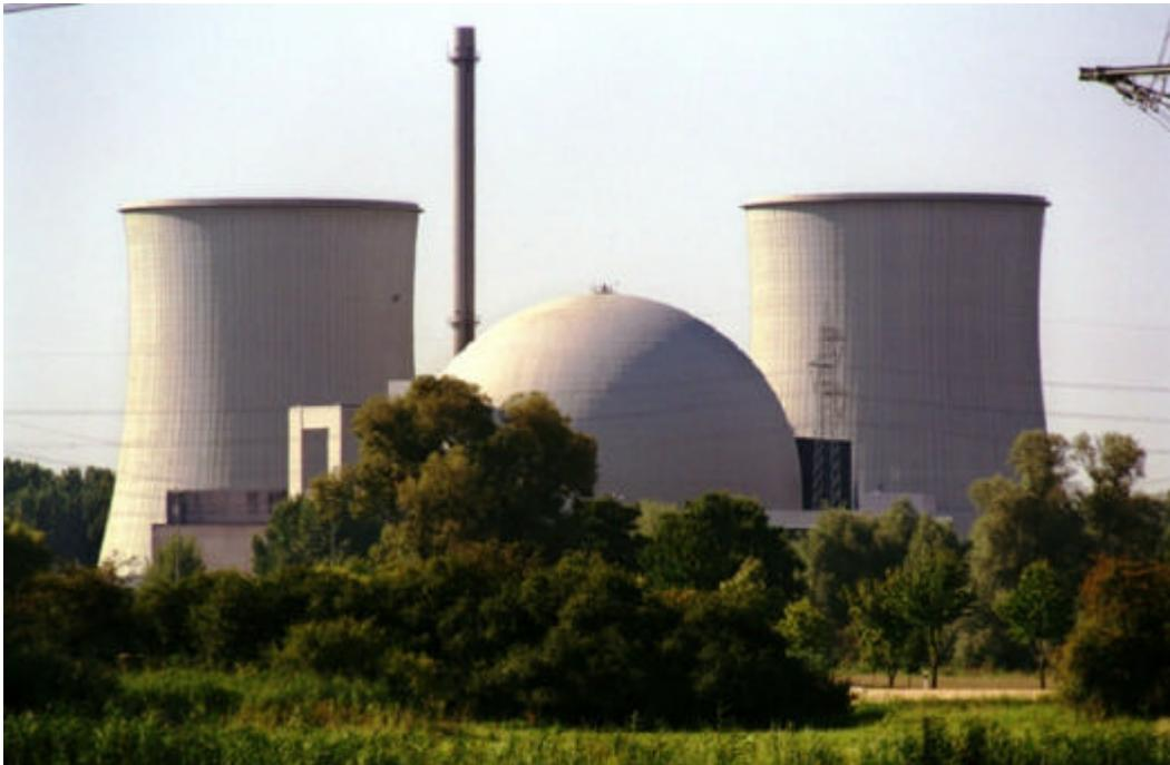
Abbildung 4-15: Das Bild zeigt das Atomkraftwerk Biblis. Im dem kugelförmigen Gebäude in der Mitte ist der Atomreaktor untergebracht. Links und rechts sind die Kühltürme. Ein Atomkraftwerk nutzt den nicht-erneuerbaren Energieträger Uran. Das Atomkraftwerk nutzt die Energie von Uran zunächst, um heißes Wasser zu erzeugen. Mit dem heißen Wasser wird dann elektrischer Strom erzeugt.
