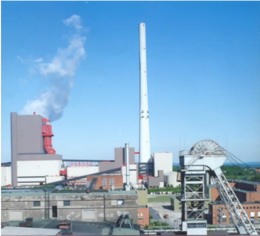
Abbildung 4-7: Das Bild zeigt ein Steinkohlekraftwerk. Der Kessel ist in dem grauen Gebäude links, wo der Dampf entweicht. Das Abgas wird durch große Rohre zum Schornstein geleitet. Das Abgas wird gewaschen, weshalb kein Staub aus dem Schornstein quillt. Rechts unten ist ein Förderturm für ein Bergwerk zu sehen.
