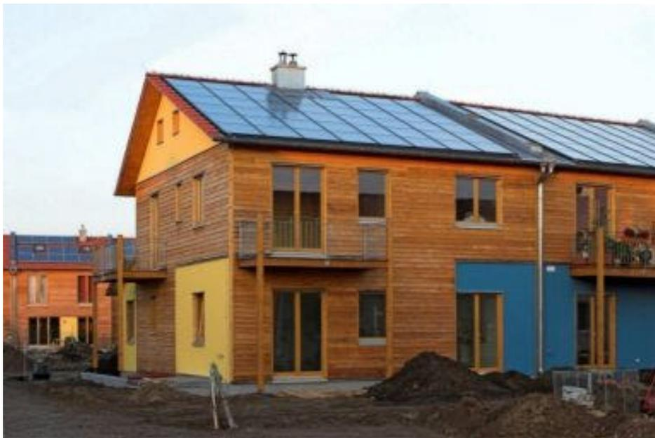
Abbildung 3-5: Das Bild zeigt Wohnhäuser aus Holz, die gerade gebaut werden. Auf den Dächern sind Fotovoltaik-Anlagen angebracht. Mit den Anlagen gewinnt man elektrischen Strom mit dem Licht der Sonne.
