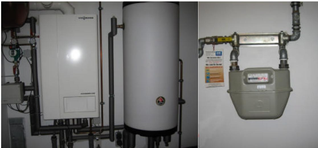
Abbildung 4-10: Das linke Bild zeigt eine Gasheizung (links) und einen Warmwasserspeicher (rechts) für das warme Wasser zum Duschen, Baden oder Geschirrspülen. Das rechte Bild zeigt den Gaszähler.
