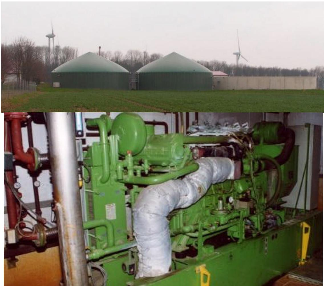
Abbildung 3-9: Das obere Bild zeigt eine Biogasanlage. Du kannst die beiden großen grünen Tanks sehen. In den Tanks entsteht das Biogas aus Gülle und Kuhfladen. Unten ist der Motor zu sehen, der das Biogas verbrennt. Der Motor treibt einen Generator an, der den elektrischen Strom erzeugt. Auch die Wärme des Motors kann man zum Heizen nutzen.
