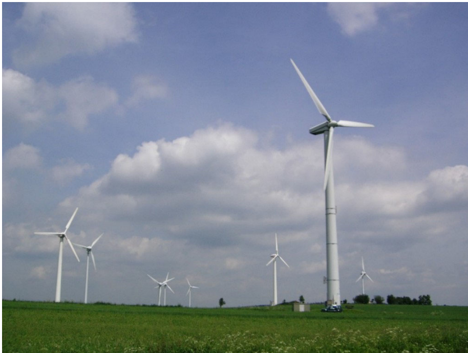
Abbildung 5-6: Das Bild zeigt Windenergieanlagen auf einem Feld. Der Generator ist in den Gondeln der Windenergieanlagen oben auf dem Turm.
