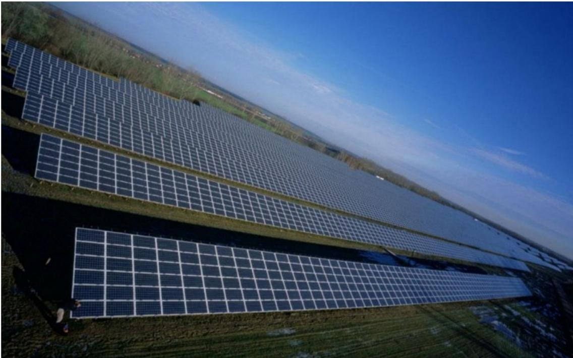
Abbildung 9-9: Das Bild zeigt eine ganz große Fotovoltaik-Anlage bei Leipzig. Die Anlage hat 33.000 Solarmodule. Mit dem Solarstrom können jedes Jahr 1.800 Familien versorgt werden. Die Anlage hat eine Leistung von 5 Megawatt. Dies sind 5.000 Kilowatt. In einer Stunde kann diese Anlage soviel elektrischen Strom erzeugen, wie eine oder zwei Familien in einem Jahr nutzen.
