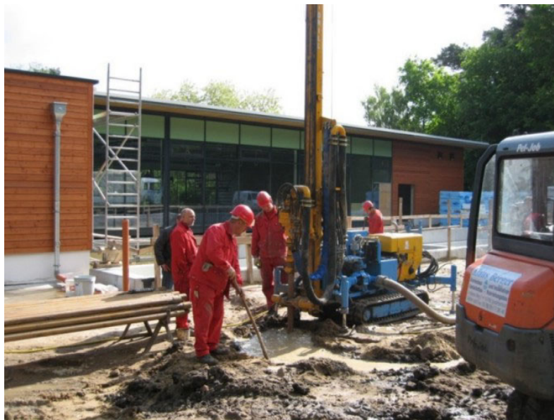
Abbildung 11-5: Das Bild zeigt eine Bohrung für eine Erdwärmeheizung. Mit der Heizung soll die Turnhalle im Hintergrund geheizt werden. Aus dem Bohrloch wird die Wärme in der Erde mit einer Wärmepumpe geholt.
