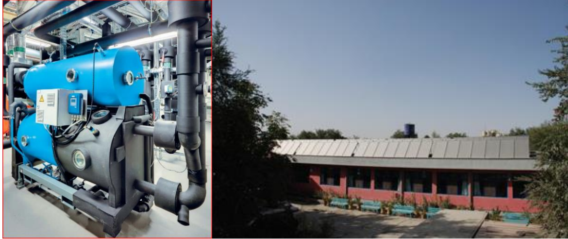
Abb.: Absorptionskältemaschine des Umweltbundesamtes Dessau und Solaranlage auf dem Kinderkrankenhaus Kabul
